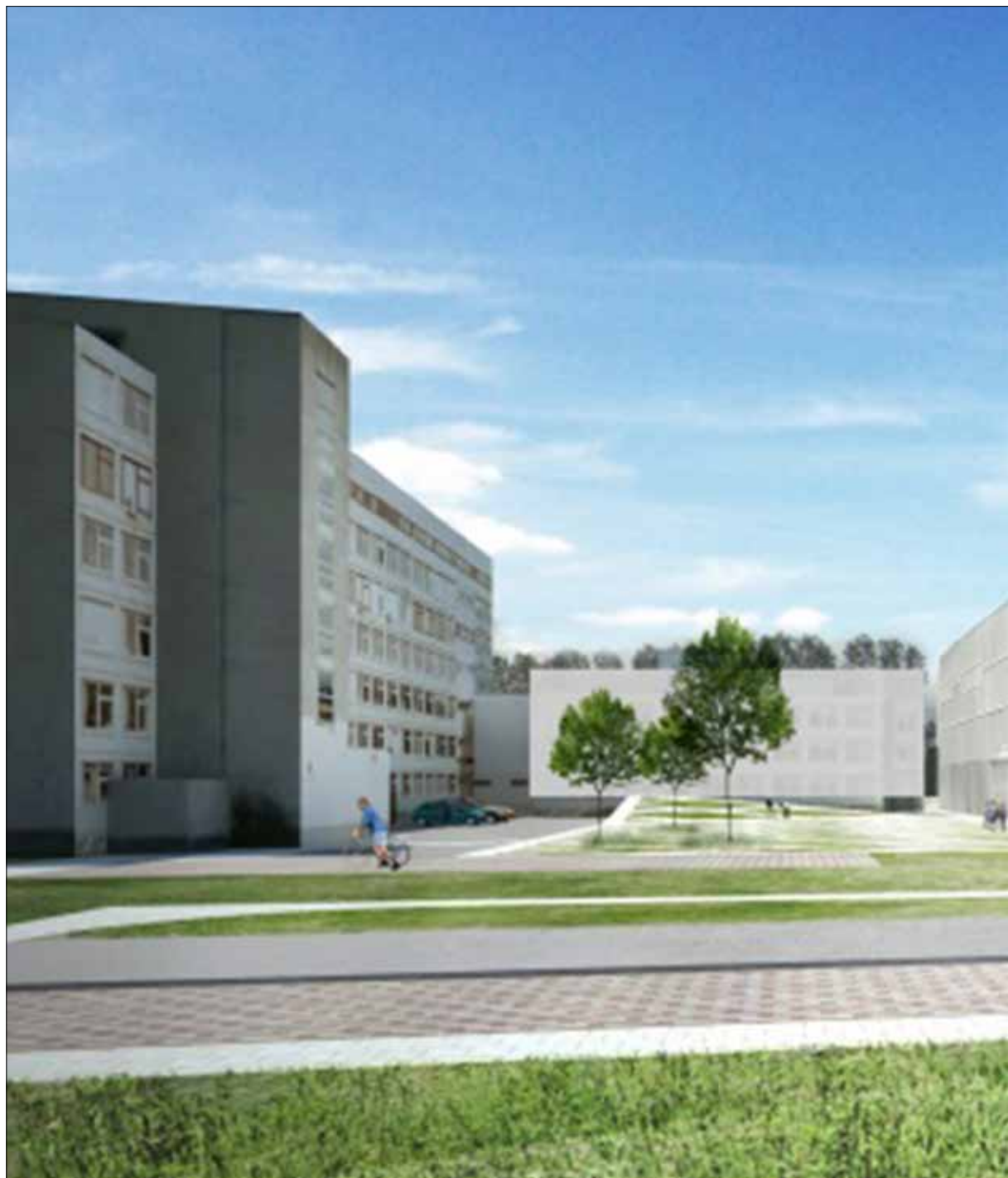
Numatomi naujieji instituto kaimynai – planuojamo VU Matematikos ir informatikos fakulteto pastato vizualizacija Santaros slėnyje.
